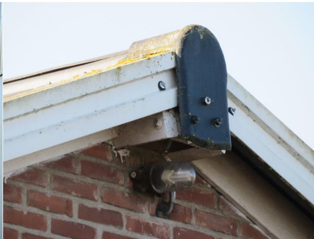
Detailfoto van de andere nok van die schuur. Geen invlieg-openingen aanwezig. Zie ook afbeelding 7.
