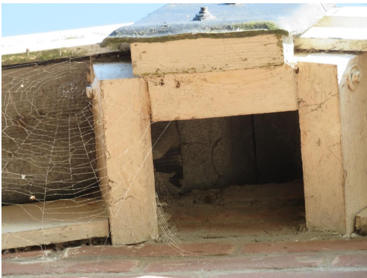
Afbeelding 7: Close-up van de nok van schuur 2 op perceel D11977. De daklijst en houten balk sluiten goed aan op de bakstenen muur.
