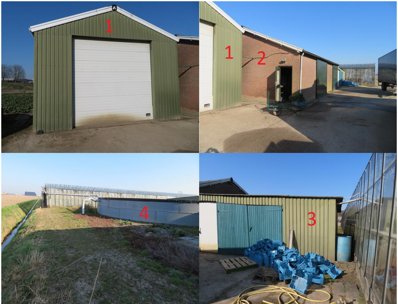
Afbeelding 5: Schuren en waterreservoir (nr. 4) op perceel D11977.
