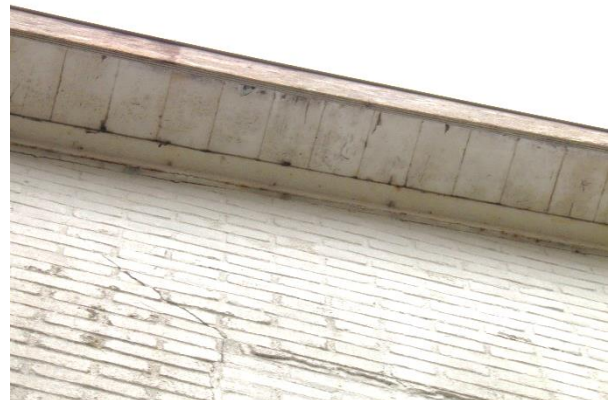
Figuur 10. Het houtwerk bij de transformator sluit naadloos aan op de buitenmuur.
