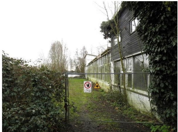
Figuur 5. Het gebouw met de transformator gezien vanuit het westen.
