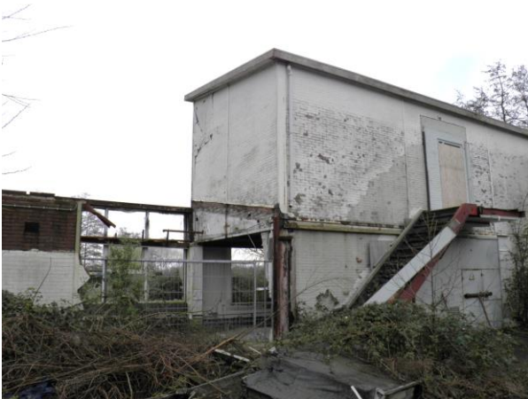
Figuur 4. Het oostelijke gedeelte van het transformatorgebouw.
