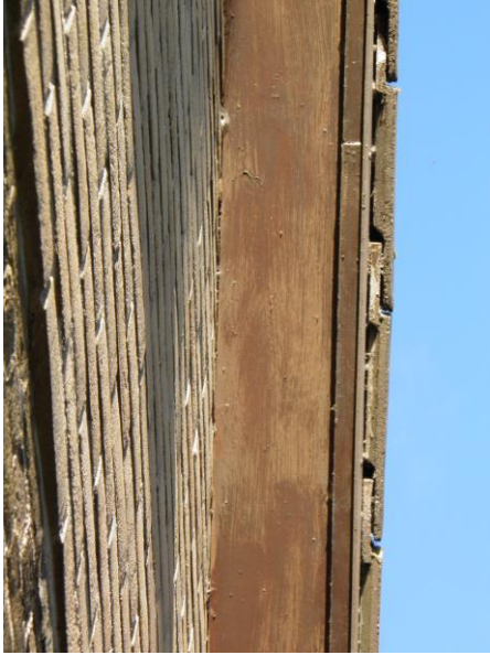
Figuur 7. De houten afwerking van de dakgoot aan de woning sluit aan op de buitenmuur.
