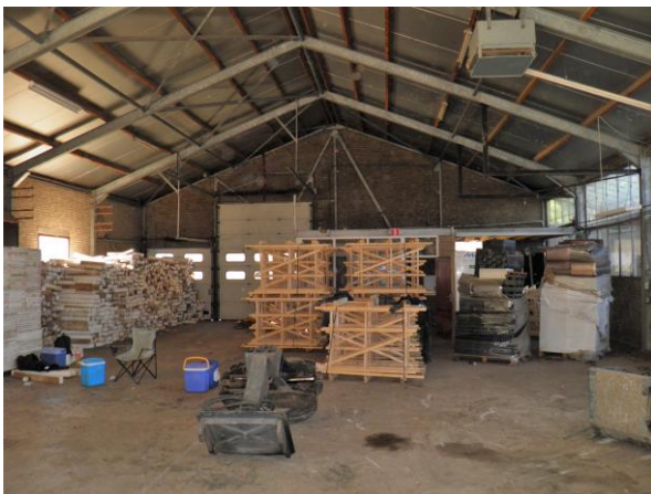
Figuur 9. Binnenzijde van de bedrijfsruimte voor het kassencomplex.
