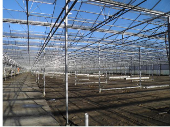
Figuur 4. Overzicht van het kassencomplex.
