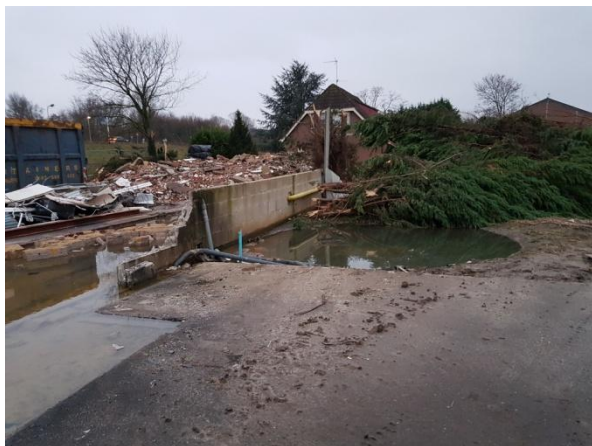
Foto 1: restanten van de woning en schuur op 7-1-19
