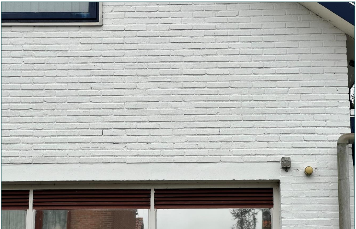
Figuur 4 De stootvoegen zijn dermate nauw dat deze ongeschikt zijn als invliegopening voor vleermuizen.
