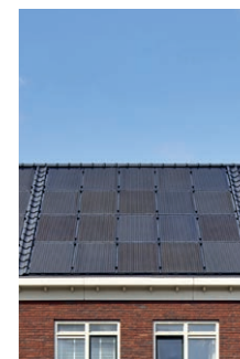
Geïntegreerde zonnepanelen
