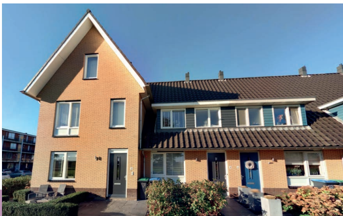
Eenvoudige hoofdvorm (huidige bebouwing aan de Sikkelwei)
