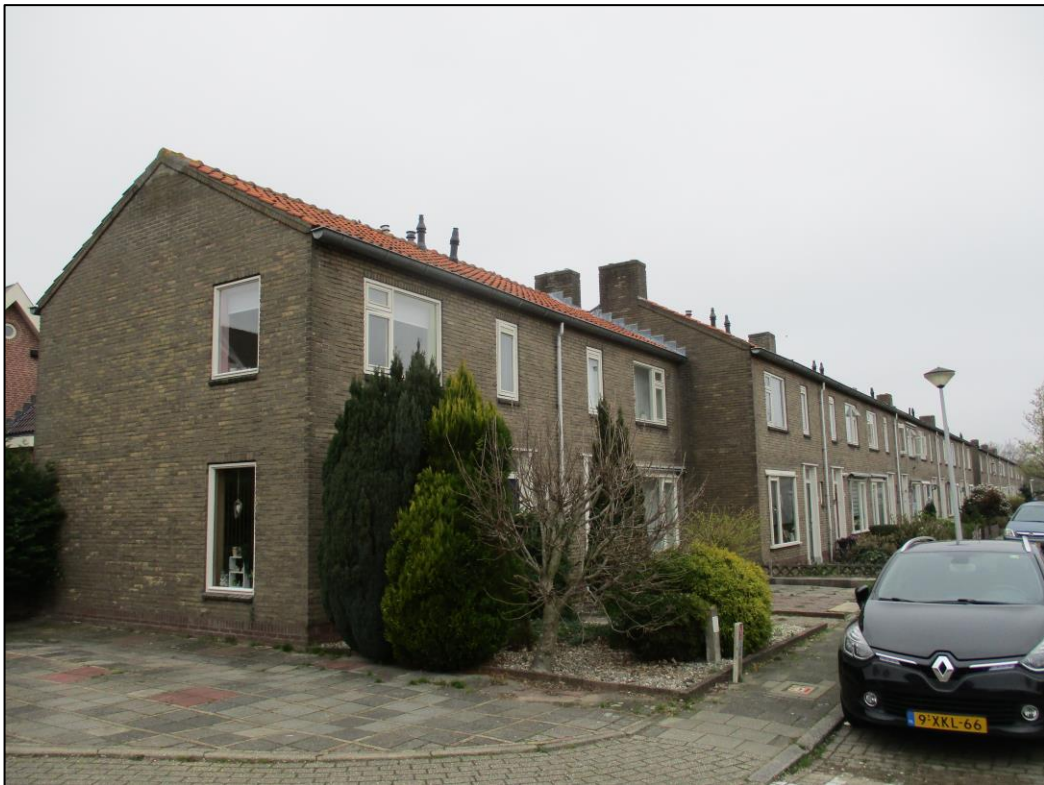
Figuur 1.2 De bebouwing op de planlocatie betreffen woonblokken met twee bouwlagen, stenen muren met spouw en een zadeldak met dakpannen.
