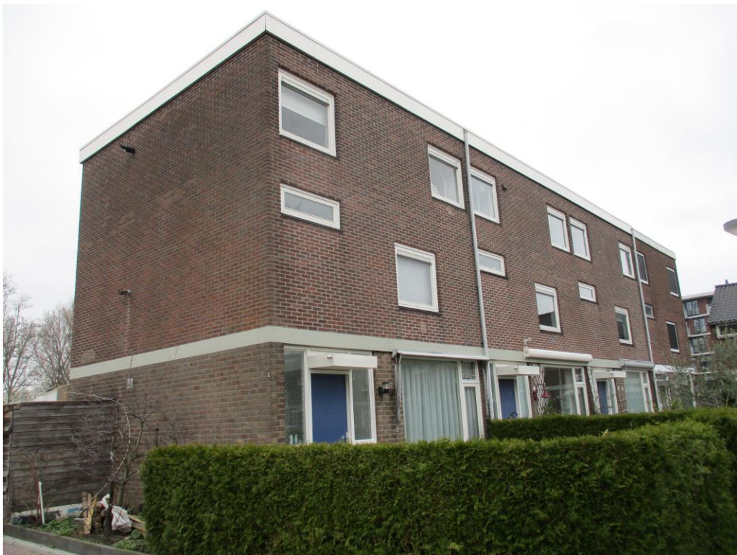
Figuur 12 Woningen in de ander bouwstijl bezitten een plat bitumen dak en hebben drie bouwlagen.
