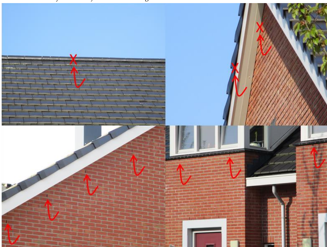
Figuur 34 Voorbeelden van potentiële invliegopeningen voor vleermuizen.
