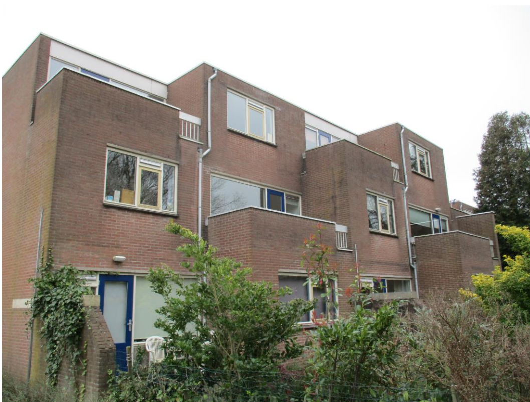
Figuur 16 De appartementen bezitten een plat bitumen dak en hebben drie bouwlagen.
