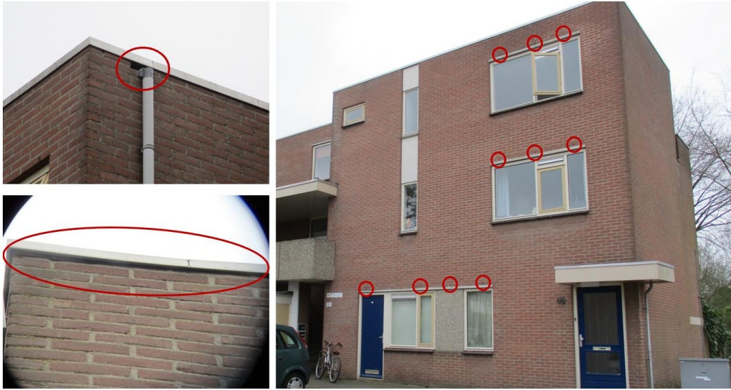
Figuur 17 Voorbeelden van potentiële invliegopeningen voor vleermuizen in de appartementen aan de Bark 103 t/m 203 (oneven) te Barendrecht.
