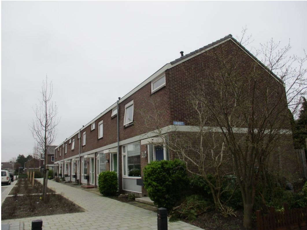
Figuur 11 De woningen in de Fruitwijk zijn opgebouwd uit twee verschillende bouwstijlen. De meeste woningen bezitten een zadeldak met dakpannen en hebben twee bouwlagen.
