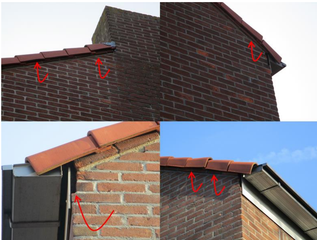
Figuur 9 Voorbeelden van potentiële invliegopeningen voor vleermuizen en gierzwaluwen. Daarnaast zijn de onderste rij dakpannen toegankelijk voor huismussen.
