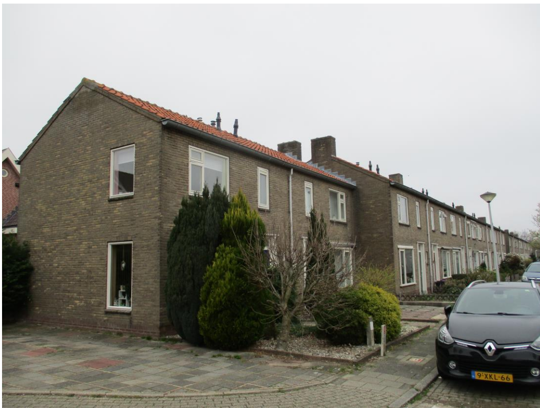
Figuur 4 De planlocatie aan de Trompstraat betreft enkele rijtjeswoningen bestaande uit twee bouwlagen.
