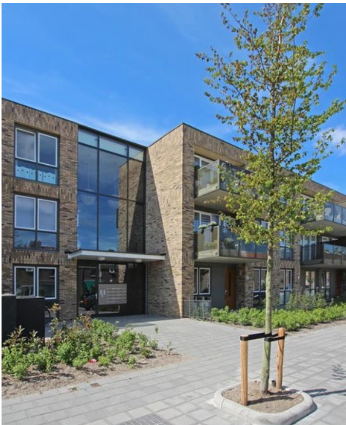
Verspringing in rooilijn appartementencomplex
