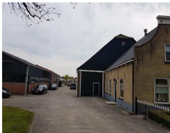
Foto 4: onderzoekslocatie gezien vanaf het noorden
