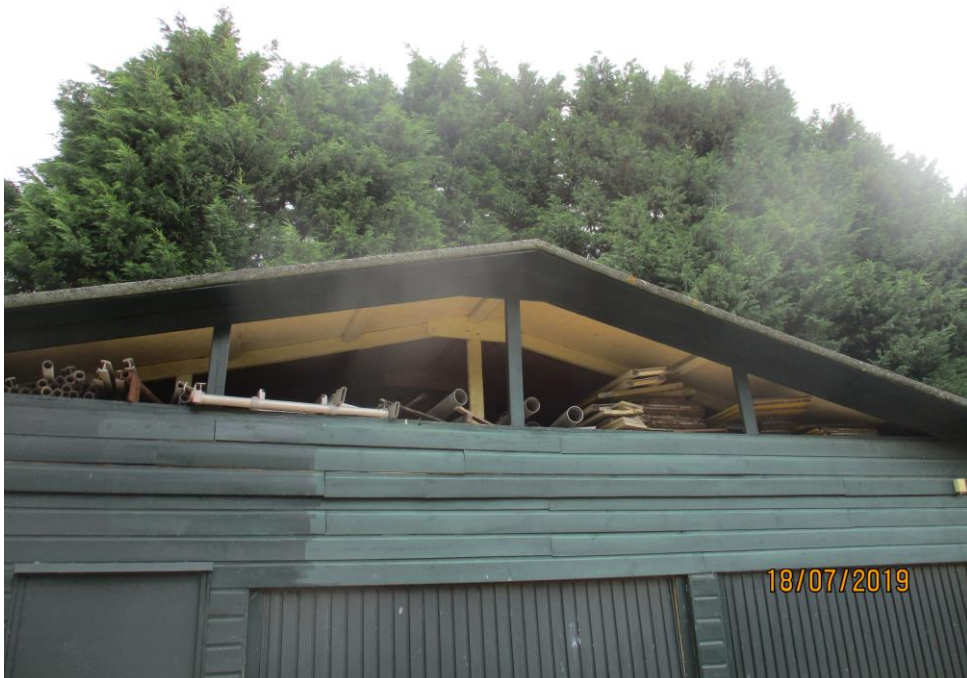
Figuur 6 Schuur F, hout en bouw materiaal opslag, enkel laags houten muren met plat zadeldak.
