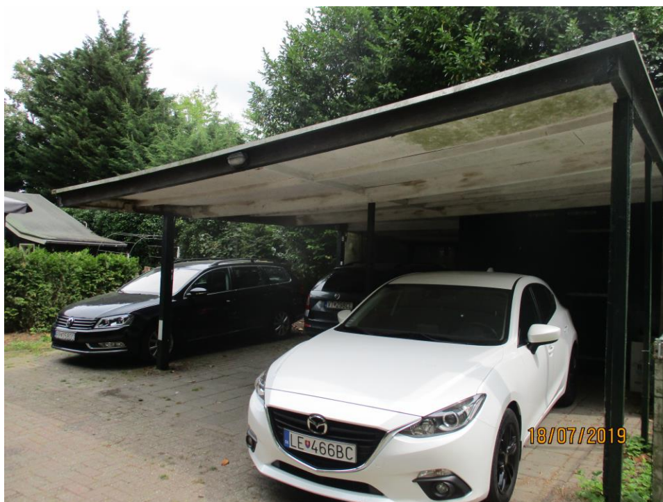
Figuur 2 Gebouw B, een carport met plat dak en enkel laags houten achterkant.
