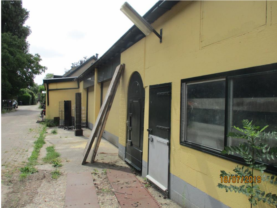
Figuur 5 Gebouw E, houtopslag en veestal functie, beton blokken muren met een golfplaten zadeldak en goot.
