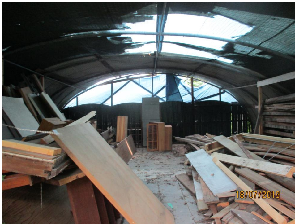
Figuur 3 Schuur C, opslag van hout en meubels, stalen constructie met plastic zeil
