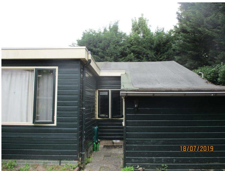
Figuur 1 Gebouw A, bungalow zonder spouw, goed aansluitende daklijsten en een plat dak.
