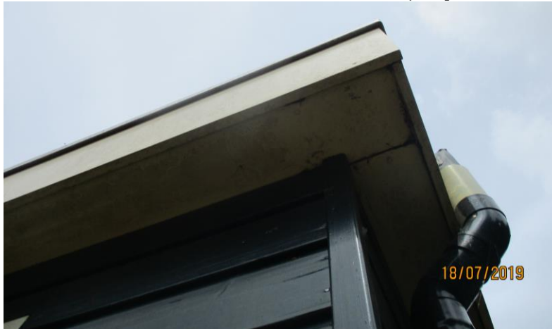
Figuur 3 Aansluitende daklijst, bungalow (A)
