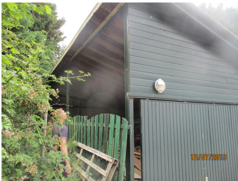
Figuur 4 Schuur D, hout en schutting opslag, enkel laags houten muur met (schuin) plat dak.
