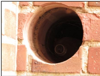
Figuur 9. Open toegang tot de spouwmuur. Biedt verblijfsmogelijkheden voor vleermuizen.
