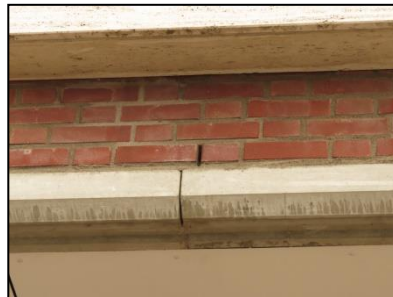
Figuur 10. Open stootvoegen die toegang bieden tot de spouwmuur. Biedt verblijfsmogelijkheden voor vleermuizen.
