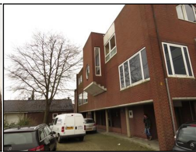
Figuur 4. Noordzijde van het schoolgebouw.
