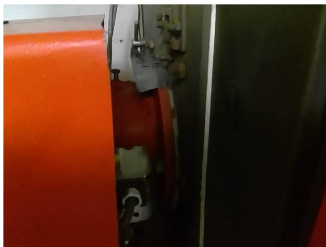
Foto 5 | Foto voor bron Pakking tussen brander en branderplaat
