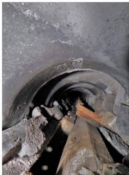
Figuur 9. Ondanks het grote gat bij de nok waren hier geen gebruikssporen van dieren.
