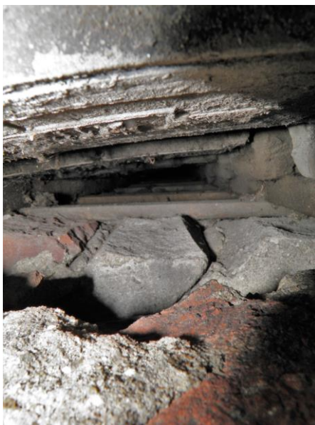
Figuur 8. Doorzicht op het dakvlak aan de voorzijde van de woning.
