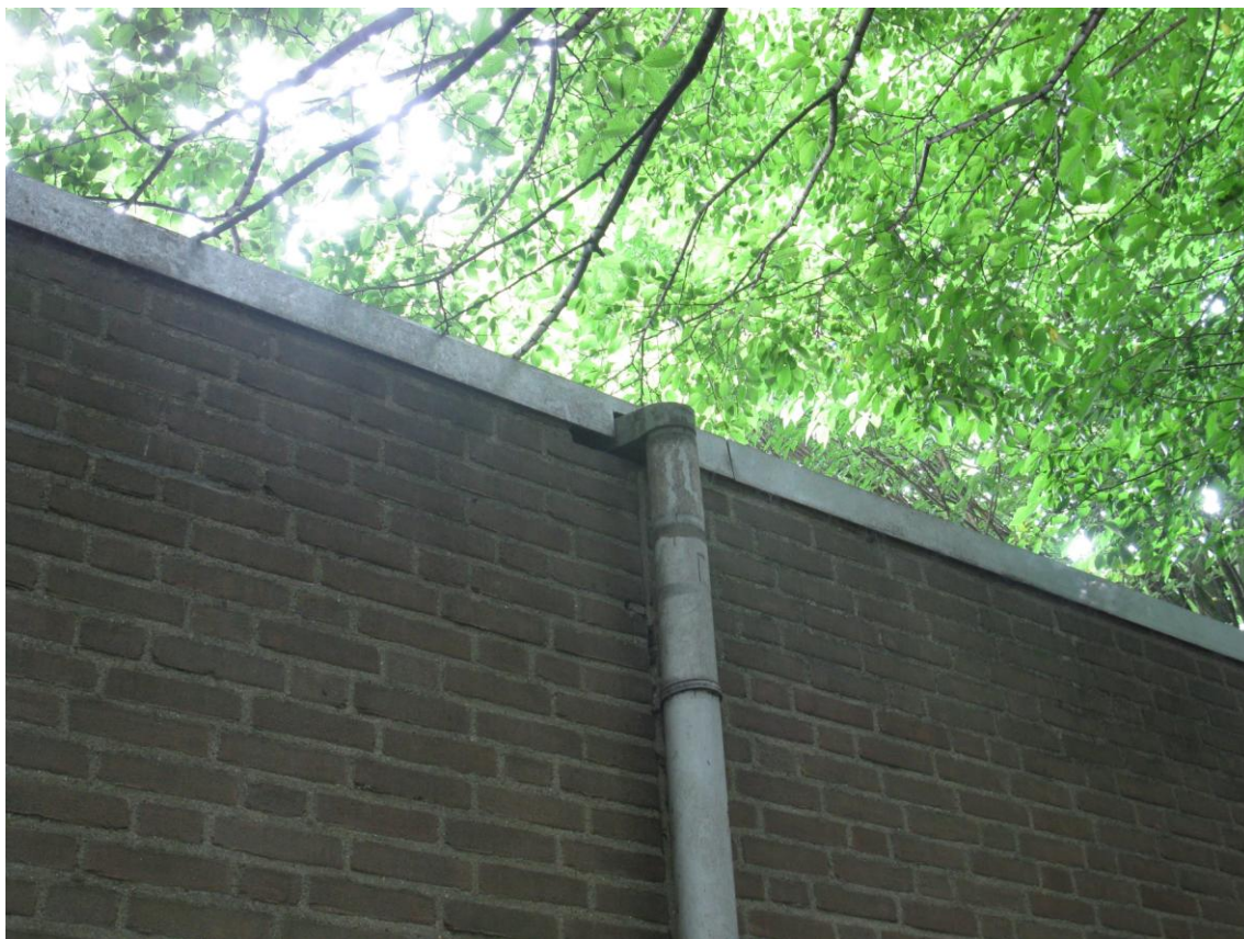
Foto 3: Opening onder regenpijp waarlangs vleermuizen onder andere de spouw kunnen bereiken
