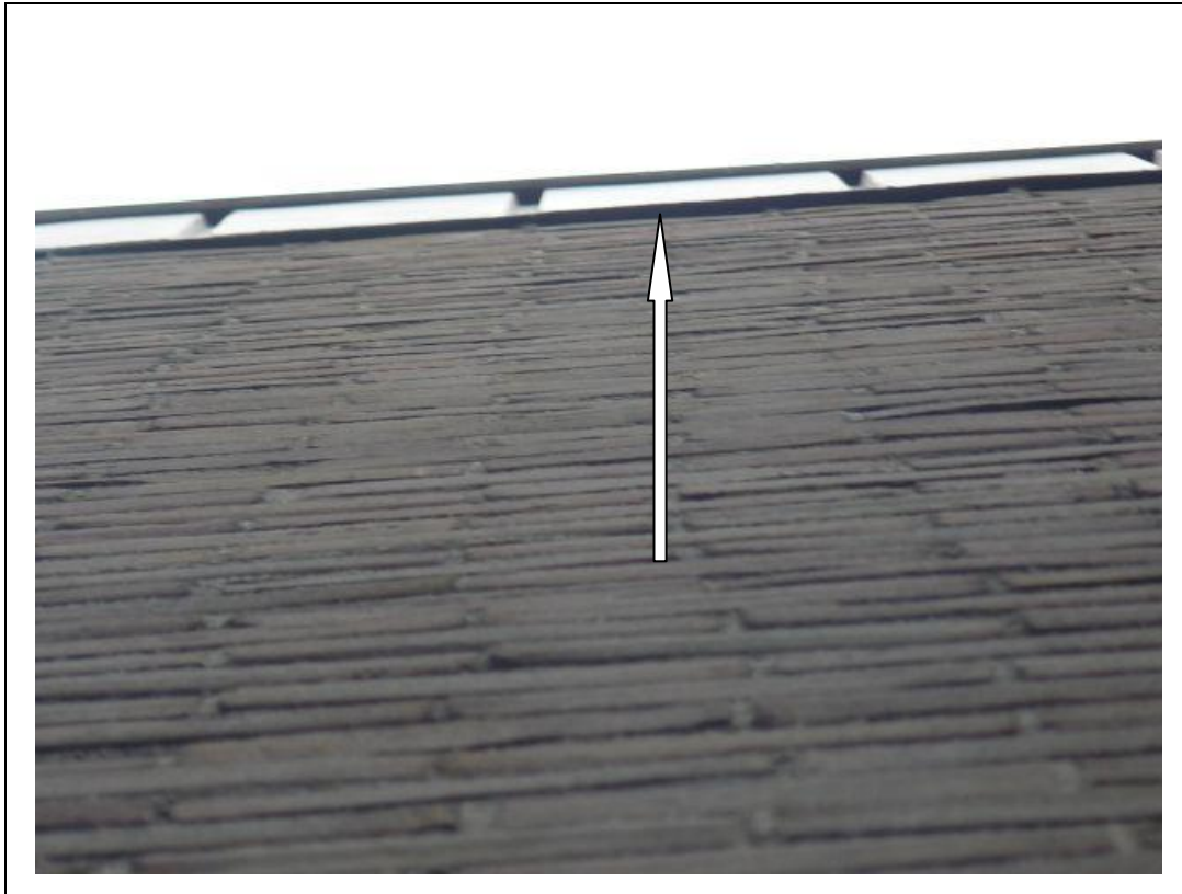
Foto 5. Ruimte onder de dakrand.
