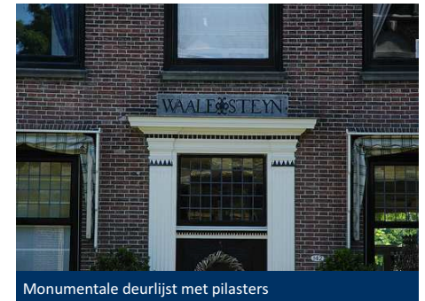
Monumentale deurlijst met pilasters
