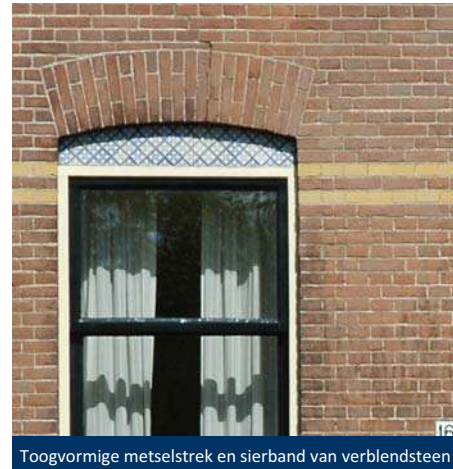
Toogvormige metselstrekk en sierband van verblendsteen
