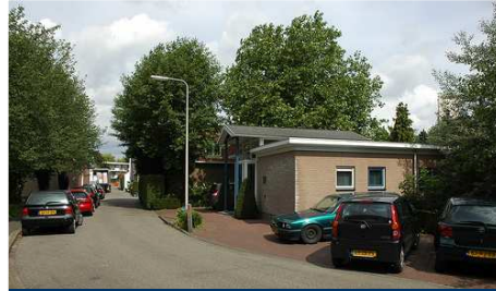
Singel heeft smal profiel en geasfalteerde rijbaan
