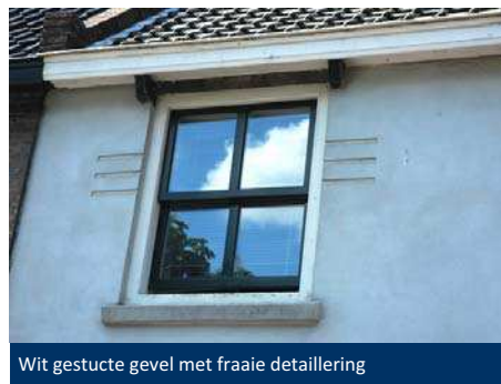
Blokbepleistering met schijnvoegen
