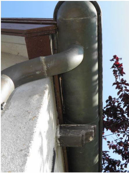
Figuur 9. Het houtwerk van het dak op het woonhuis sluit aan bij de regengoot en buitenmuur.
