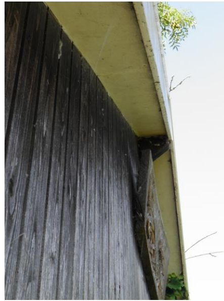
Figuur 10. Het houtwerk van de schuur sluit naadloos op elkaar.
