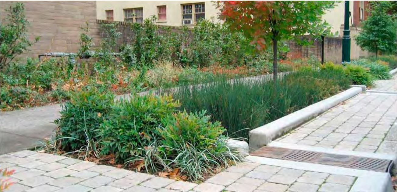
Infiltratiegoot met vochtminnende beplanting
