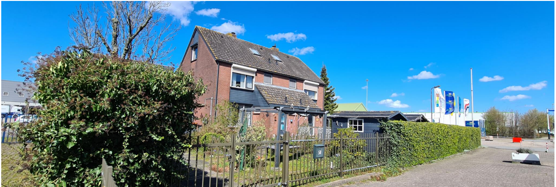
Figuur 1: De woningen aan de Gebroken Meeldijk 56 en 58
