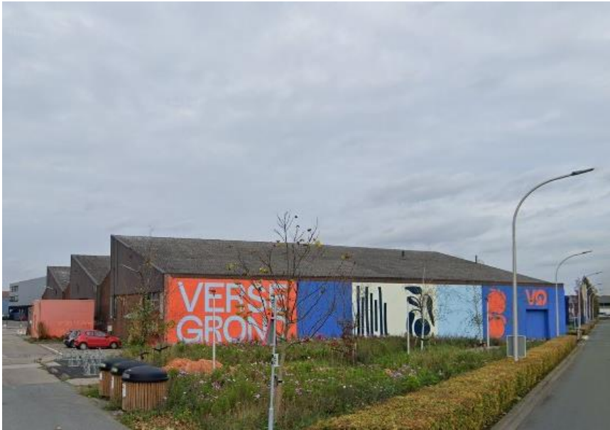
Figuur 4: Logistiek gebouw aan de Spoorlaan
