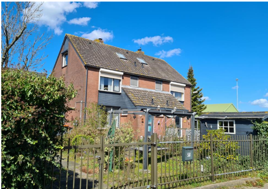
Figuur 4: De woningen aan de Gebroken Meeldijk 56 en 58
