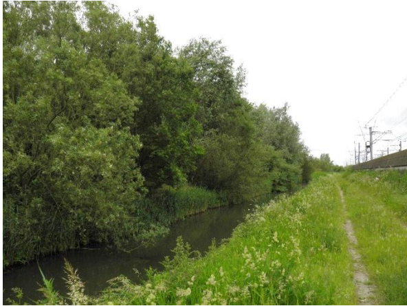
Figuur 2. Overzicht van het talud aan de noordzijde van het plangebied.
