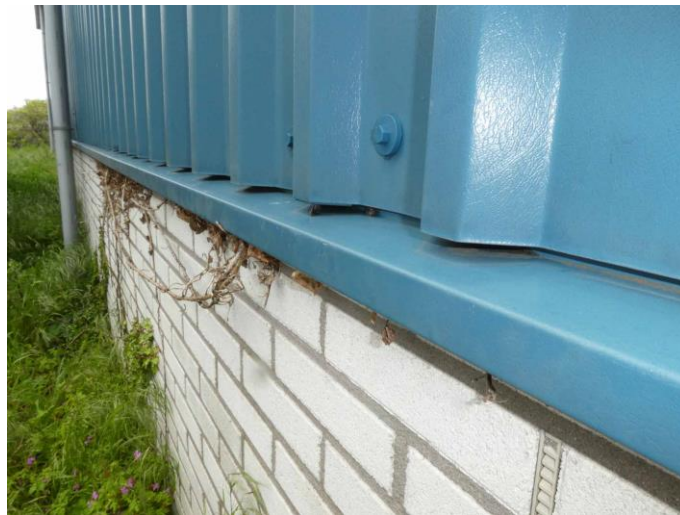
Figuur 14: Detail overgang muur - golfwanden
