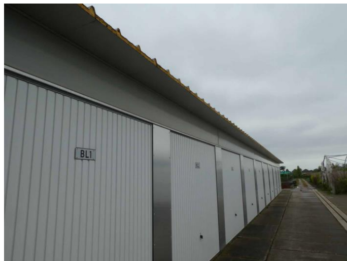
Figuur 24: Detail zijkant bedrijfsunits
