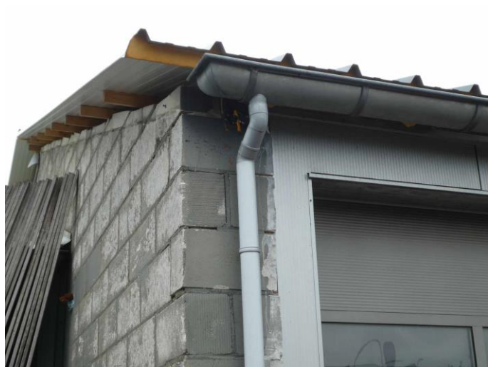
Figuur 22: Detail betonstenen muur
