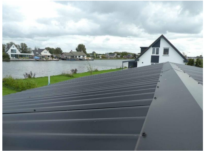
Figuur 42: Nieuwe dak van de schuur
