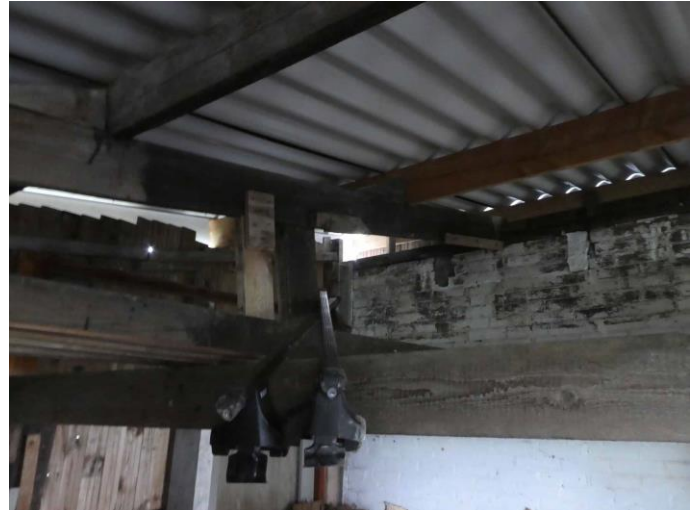
Figuur 43: Tochtruimte tussen muren en dak
