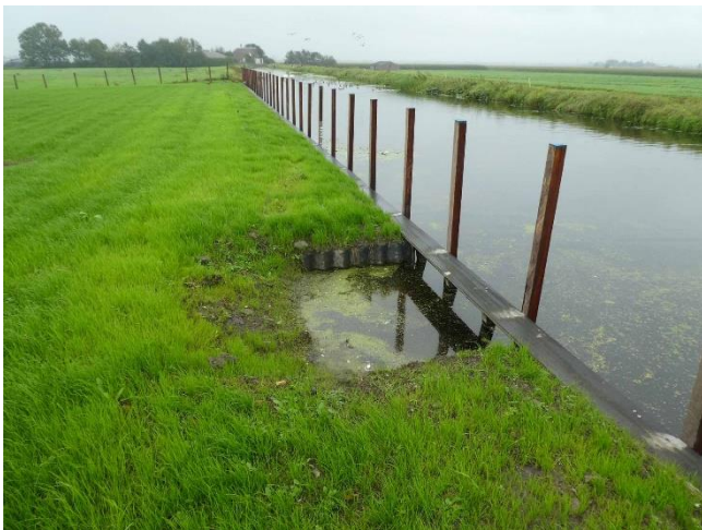
Figuur 30: Beschoeiing met toegangsplek voor fauna
