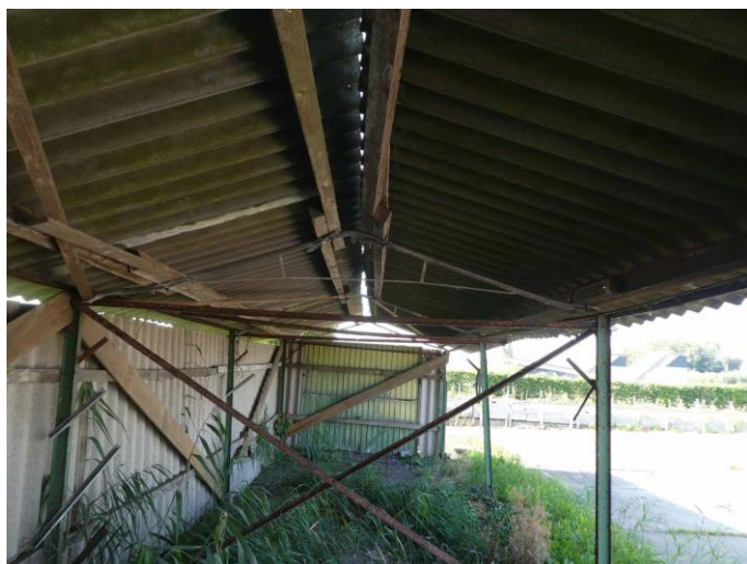
Figuur 15: Overkapping zuideinde perceel
