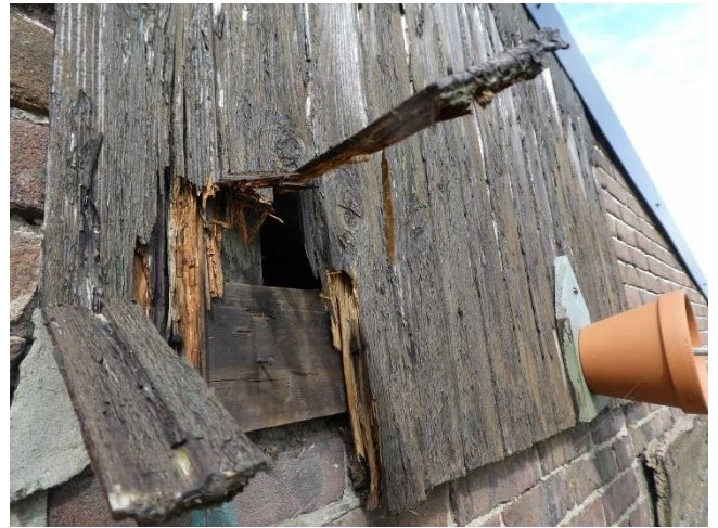
Figuur 45: Open ruimte achter houten schot, opengetrokken met een koevoet
