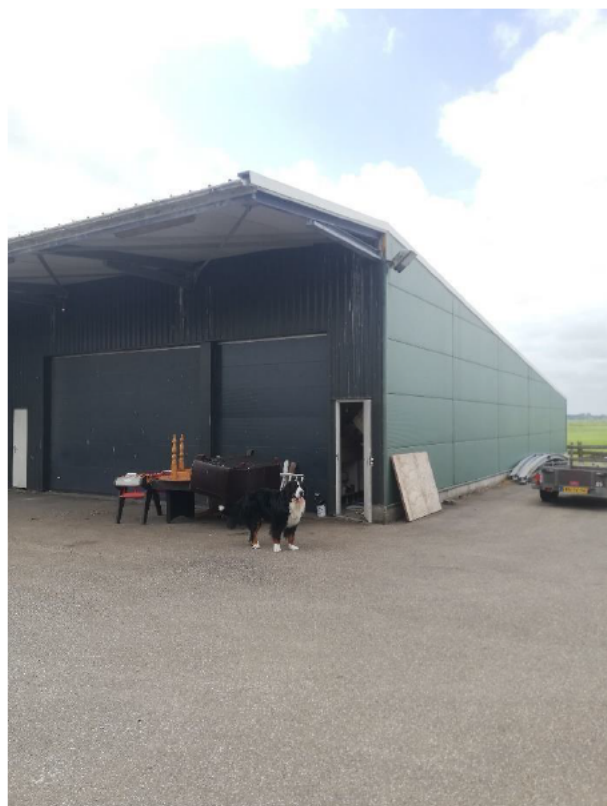
Figuur 4.1.3. De loods met het sandwichpanelen dak.
