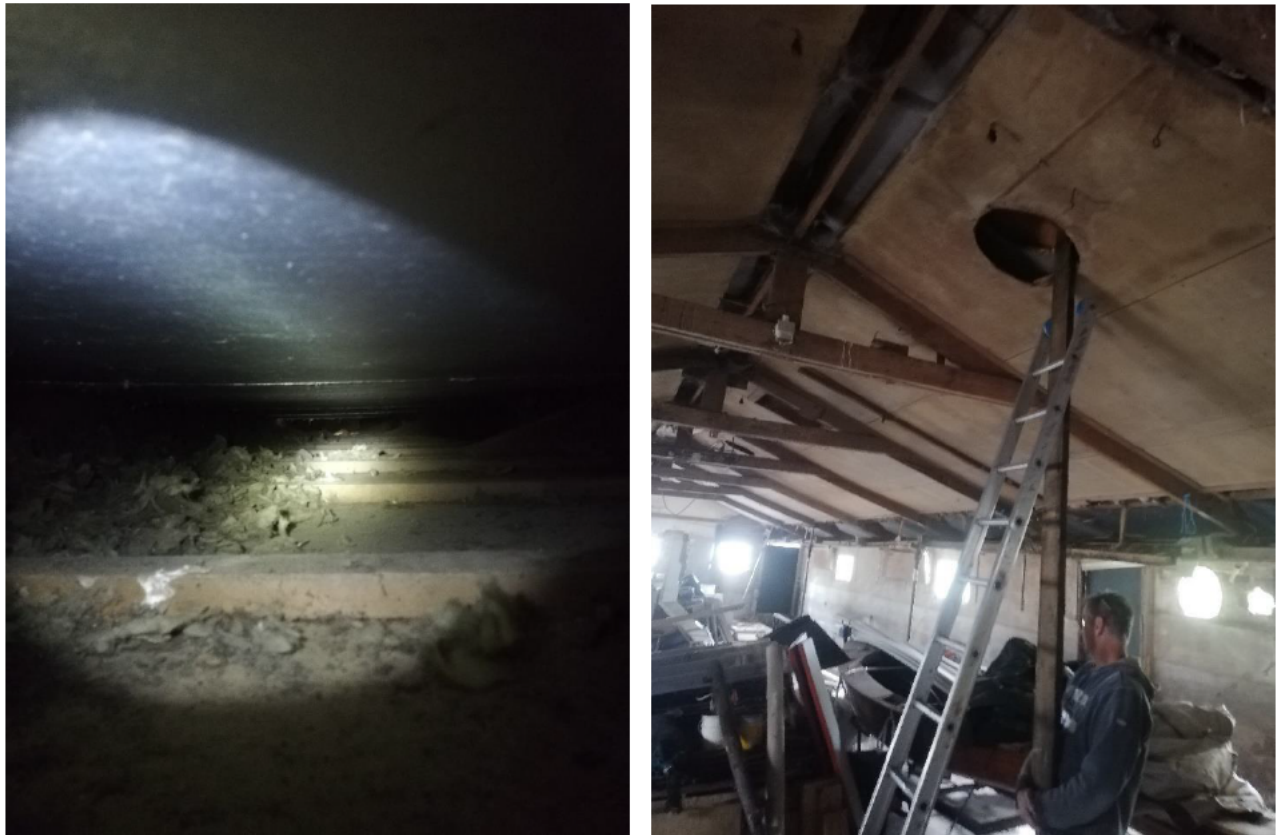
Figuur 4.4.1. Links: zicht op de plafondplaten van de voormalige varkensstal. Rechts: de ladder staat onder een van de openingen van waaruit het volledige plafond op de varkensstal kon worden geïnspecteerd.
