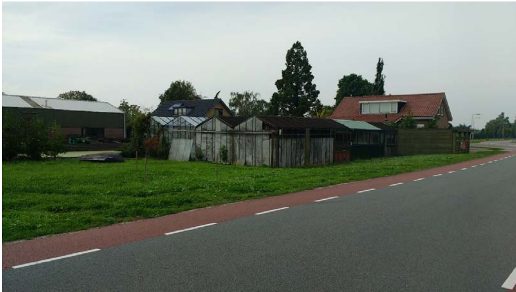
Foto 4: Oude kas/schuur die verwijderd zal worden voor de realisatie van het paviljoen.
