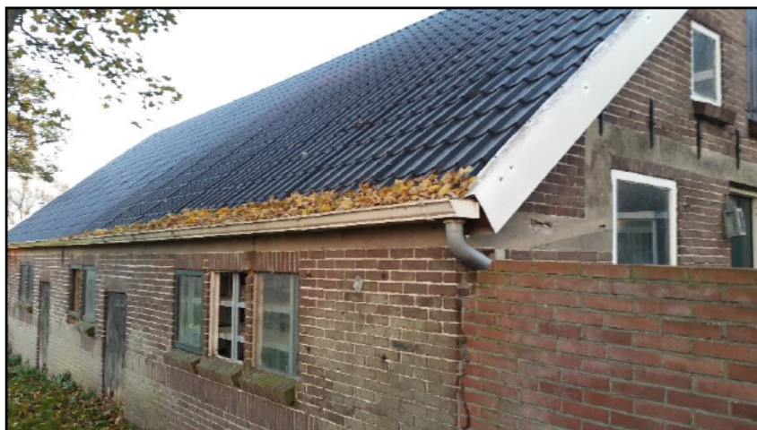
Figuur 1b westgevel voormalige varkensschuur.
