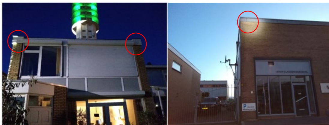
Figuur 3.2 Gevels van de gebouwen aan de Energieweg 7 (links) en 9 (rechts) waar zich 2 zomerverblijven van de gewone dwergvleermuis bevinden (rode cirkels)
