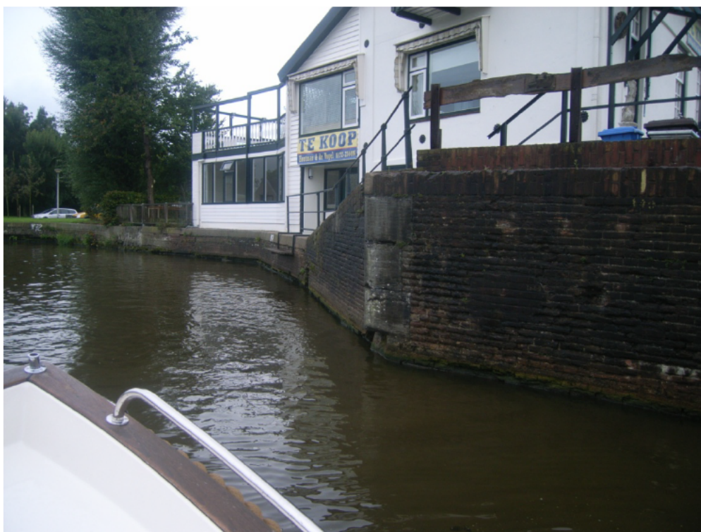
Foto 2: Zicht op het huis aan de rand van het plangebied. Camera gericht op het zuiden.
