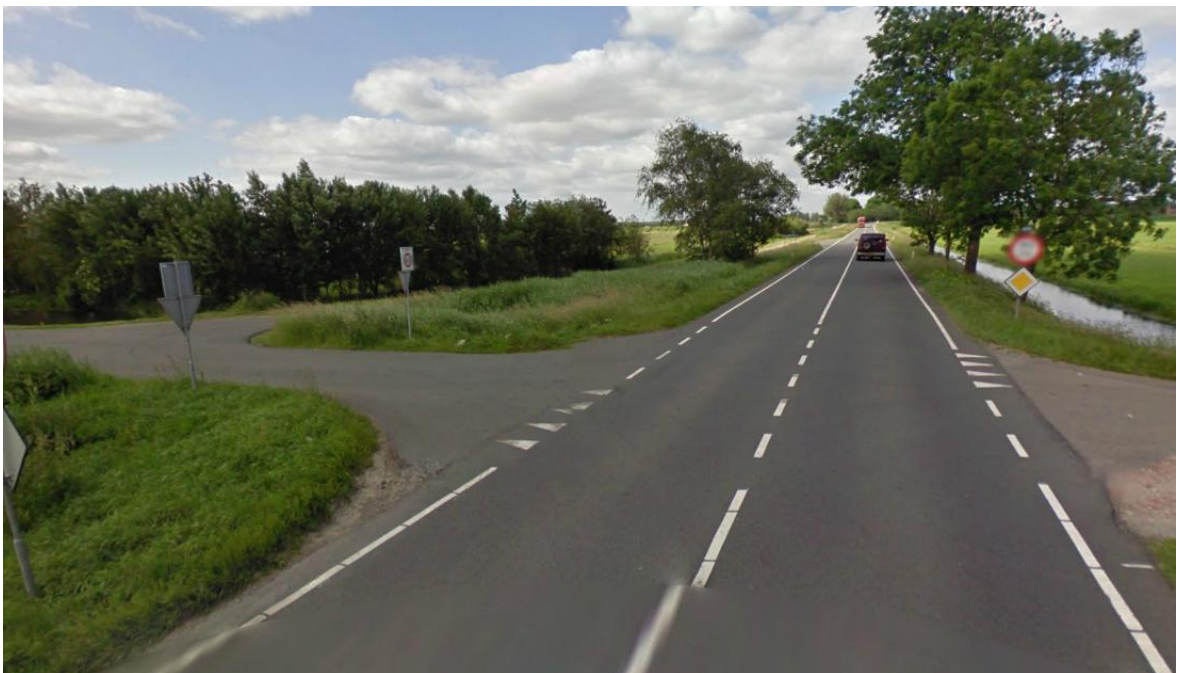
Afbeelding 2: Bestaande situatie met kruising N231a-Treinweg (boven) en kruising N231a-Achtermiddenweg (onder) (Bron: Google 2009)
