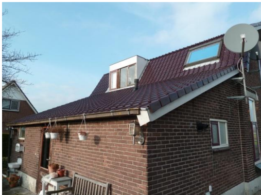
Afbeelding 2 achterzijde te slopen woonhuis
