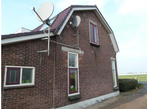
Afbeelding 1 zijkant van het te slopen woonhuis
