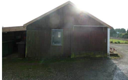
Afbeelding 3 de te slopen schuur
