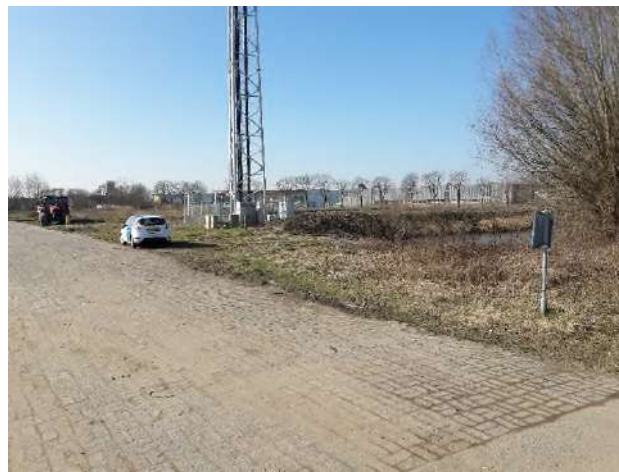
Fotonummer: 2. Telecom mast op het terrein aanwezig.
