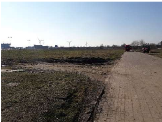
Fotonummer: 1. Werkzaamheden in uitvoering, incl gestalde voertuigen.
