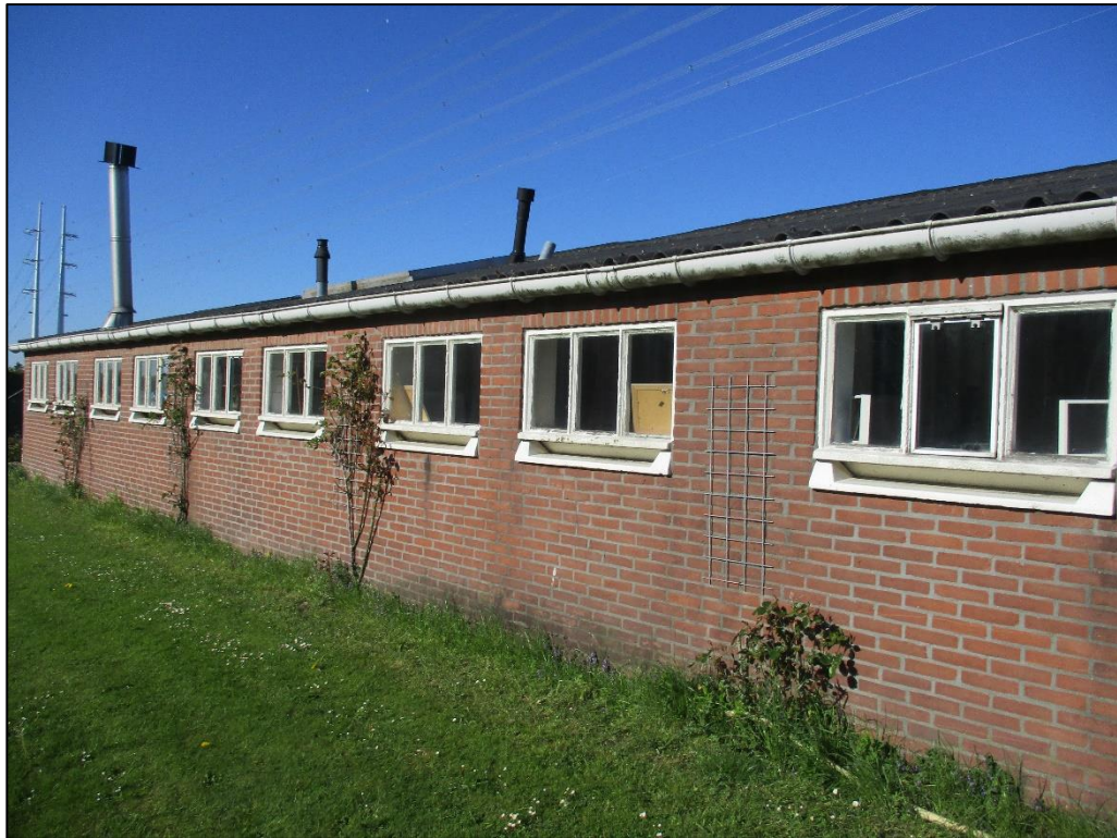
Figuur 3 De lage schuur heeft aan de kopgevel mogelijke invliegopeningen die leiden tot geschikte verblijfplaatsen voor vleermuizen.
