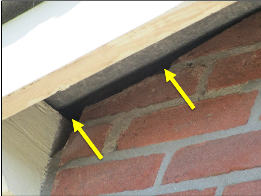
Figuur 4 Openingen aan de zuidelijke kopgevel van de lage achterste schuur waar vleermuizen toegang kunnen krijgen tot de luchtpouw.
