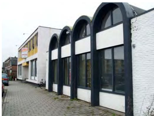
Foto 3. Voorzijde van het gebouw.
