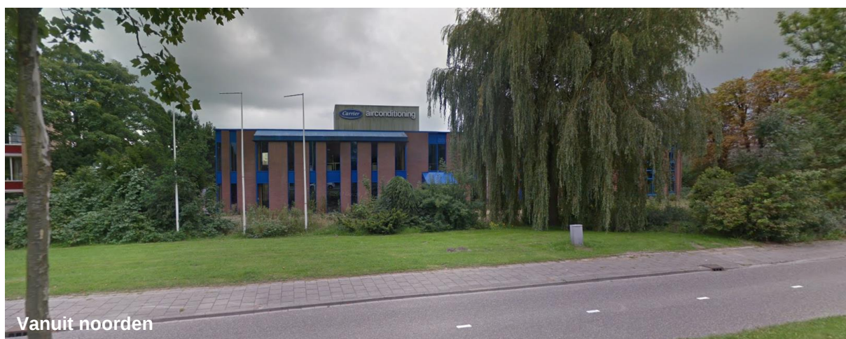
Figuur 2.1: Foto's plangebied met inmiddels gesloopte bebouwing van Carrier (bron: Google Maps)
