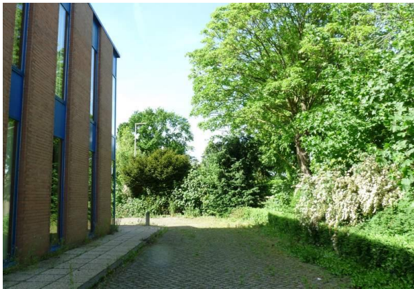
Figuur 7. Oostzijde Carriergebouw
