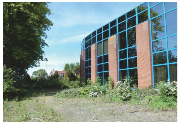
Figuur 4: Westkant van het Carriergebouw.
