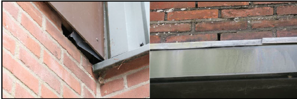
Figuur 4 De kringloopwinkel '1' en de loodsen '2' en '3' aangeduid in figuur 2 beschikken over openingen die mogelijk door vleermuizen kunnen worden gebruikt om de spouwmuur te bereiken.
