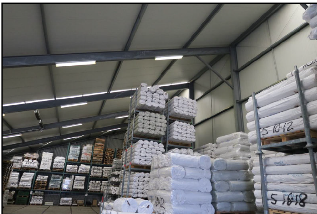
Figuur 2 De daken van de loodsen op de planlocatie zijn bedekt met een sandwichpanelen dakbedekking, of andere soorten dakbedekking waaronder nestlocaties van de huismus niet mogelijk zijn.
