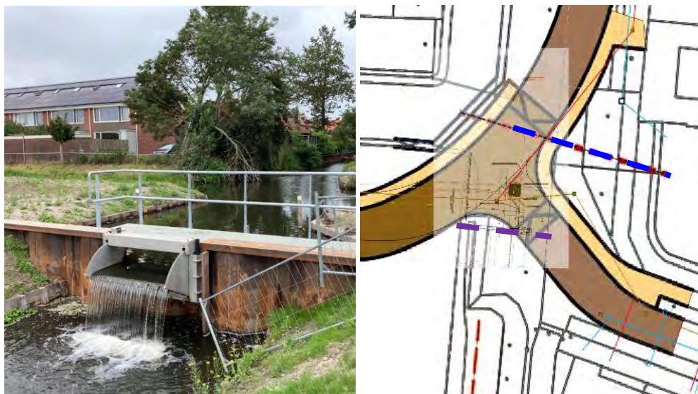
Figuur 14: overzicht huidige situatie stuw t.h.v. Jan van Eycklaan in Hazerswoude-Dorp
