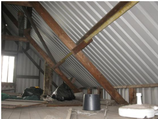
Foto 7: Enkel dak van kunststof golfplaten
