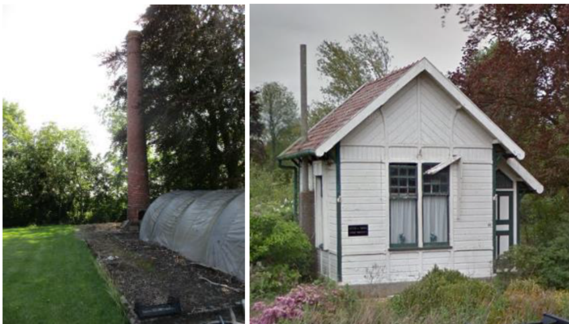
Afbeelding 4 en 5 foto bestaande schoorsteen en voormalig loonbetaalkantoortje
