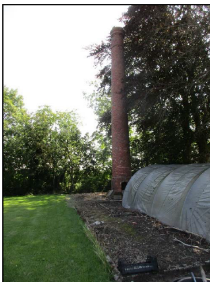
Figuur 10.1: Oude schoorsteen op het zuidelijke deel van het terrein.
