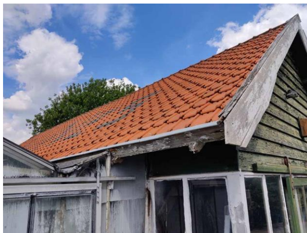
Figuur 12 Schuur met pannendak en houten enkelwandige muren met ramen
