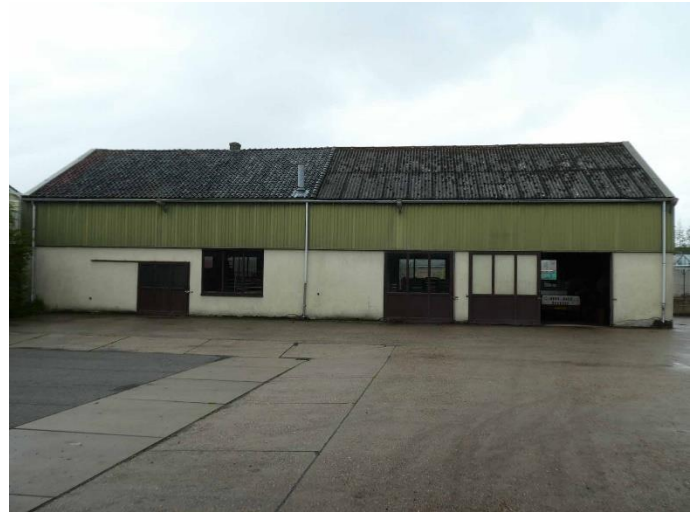
Figuur 7: Pakloods aan de zuidwestkant
