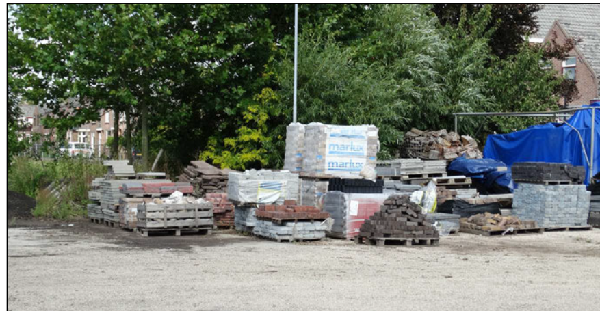
Figuur: op het terrein staan veel opstapelingen van bouwmaterialen. Vogels als winterkoning en witte kwikstaart kunnen hier tussen gaan broeden.
