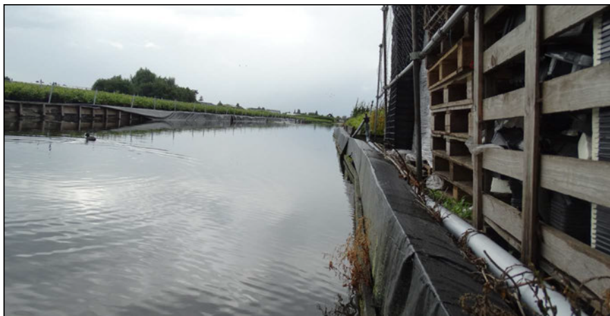
Figuur: de schoeiing is hoog en ongeschikt voor ringslang en waterspitsmuis wegens het ontbreken van dekking.
