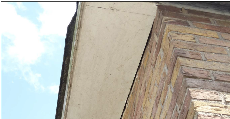
Figuur: de grote loods op het terrein bevat een kier waar dwergvleermuizen in kunnen kruipen.
