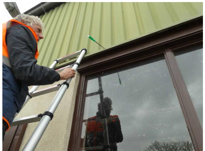
Figuur 16: Vrij hangende schroevendraaier laat zien hoe smal de aanwezige kier is.
