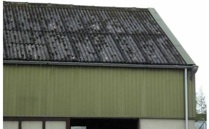
Figuur 9: Deels golfplaten dak loods (zuidwest)
