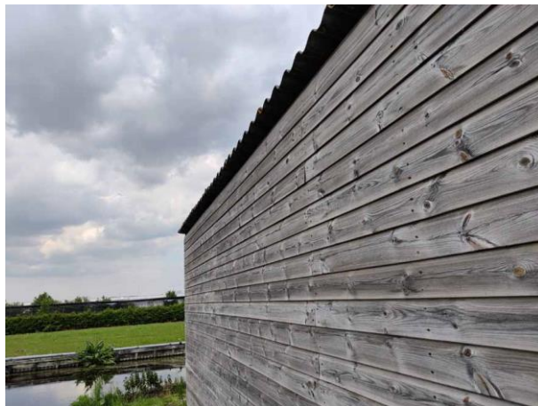
Figuur 13 Houten enkelwandige muur
