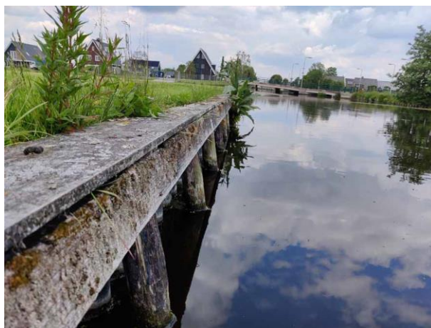
Figuur 10 Hoge hardhouten beschoeiing
