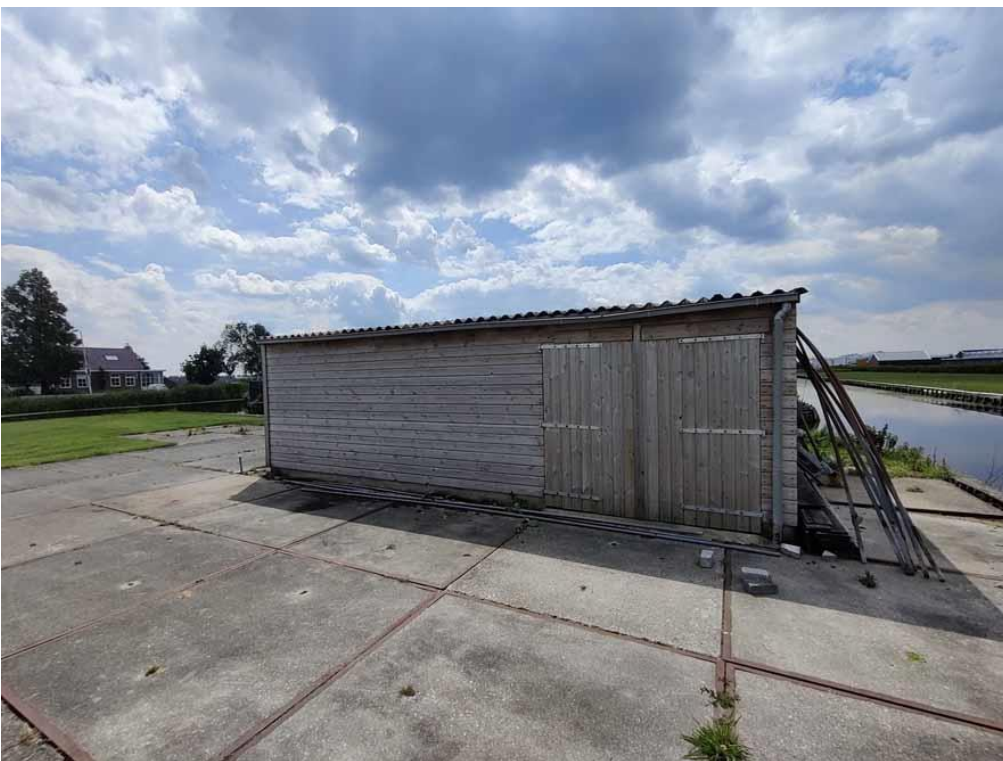
Figuur 4 Houten schuurtje omringd door betonnen platen pleintje in het zuiden van het plangebied
