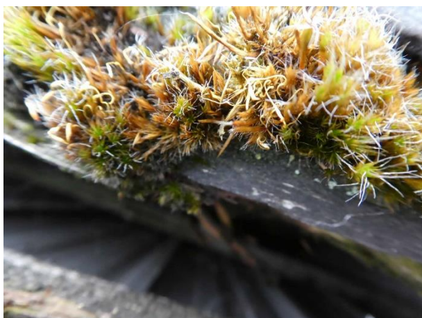
Het platte dak van de loods met begroeid met mos.
