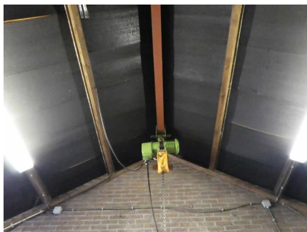
Figuur 13 Binnenzijde loods, veel lichtinval
