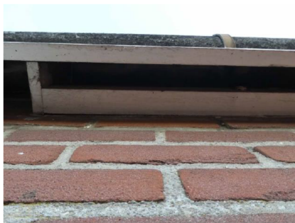
Figuur 15 Constructie waar roldeur doorheen loopt
