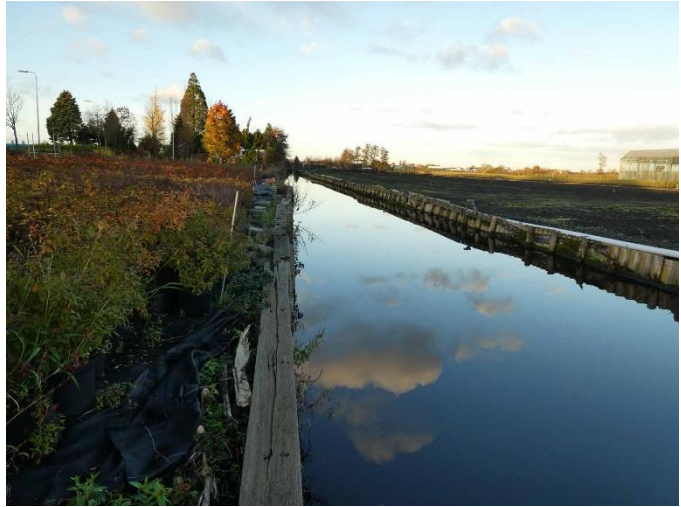
Figuur 11 Oever met hardhouten beschoeiing
