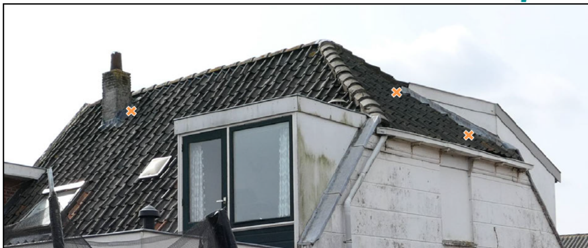
Afbeelding 4.4 Nestplaatsen van gierzwaluw onder het dak van Dorpsstraat 107 aangegeven met oranje kruizen.
