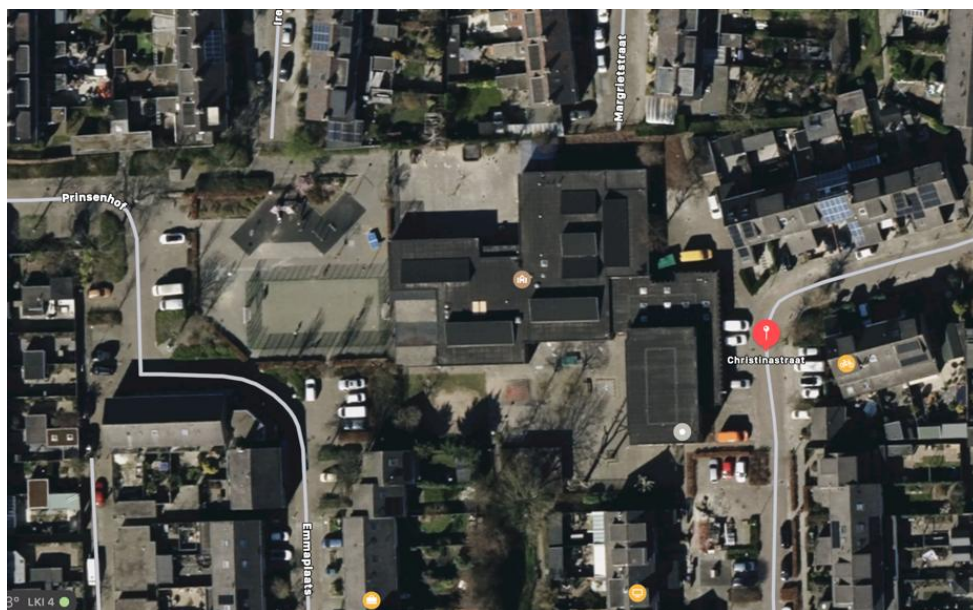
Luchtfoto huidige situatie
